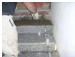
Usare gli appositi ferma gradini
