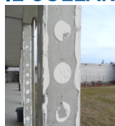
Collante insufficiente e mancanza di
